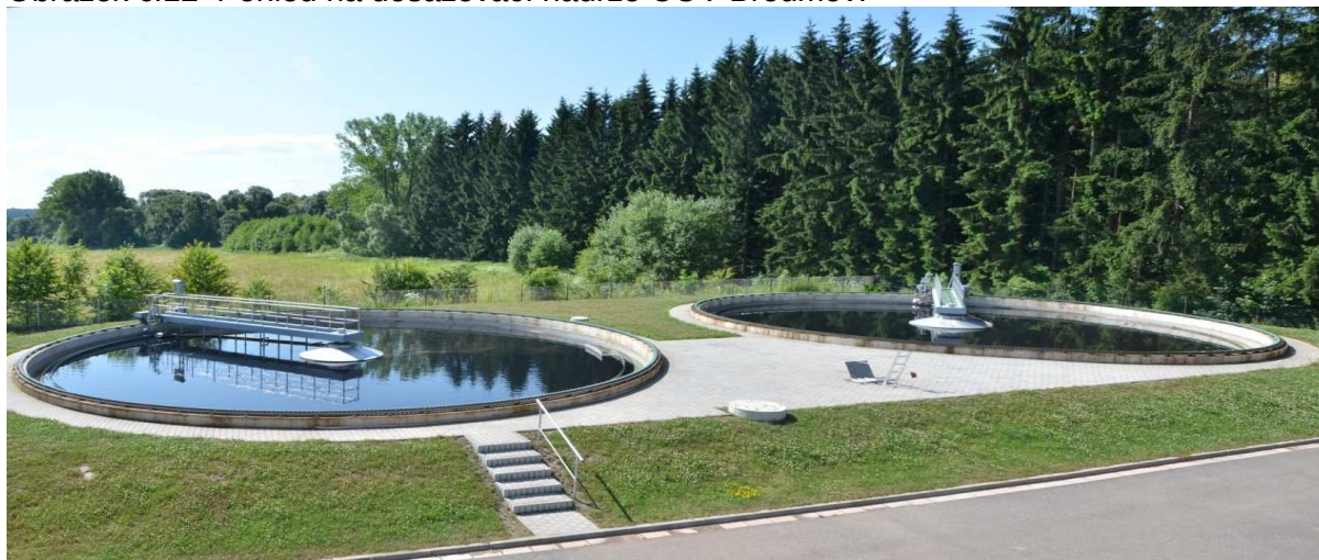
Obrázek č.12 Pohled na dosazovací nádrže ČOV Broumov.
