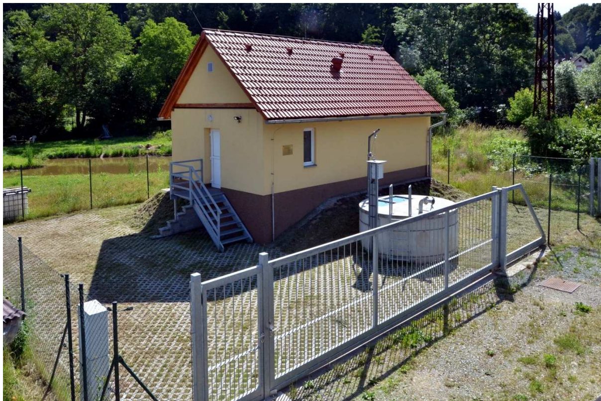
Obrázek č.10 Pohled na ČOV Nové Město nad Metují, ul. Č. Bratří
