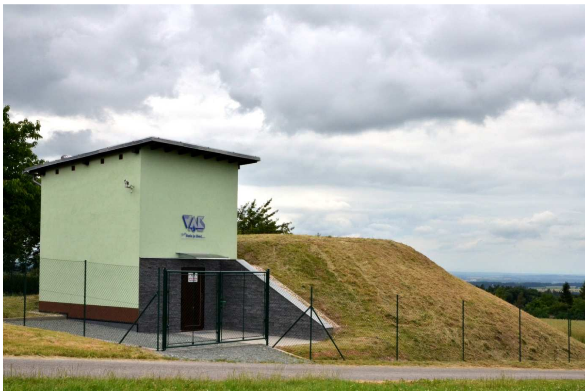
obrázek č.2 Pohled na VDJ Jestřebí
