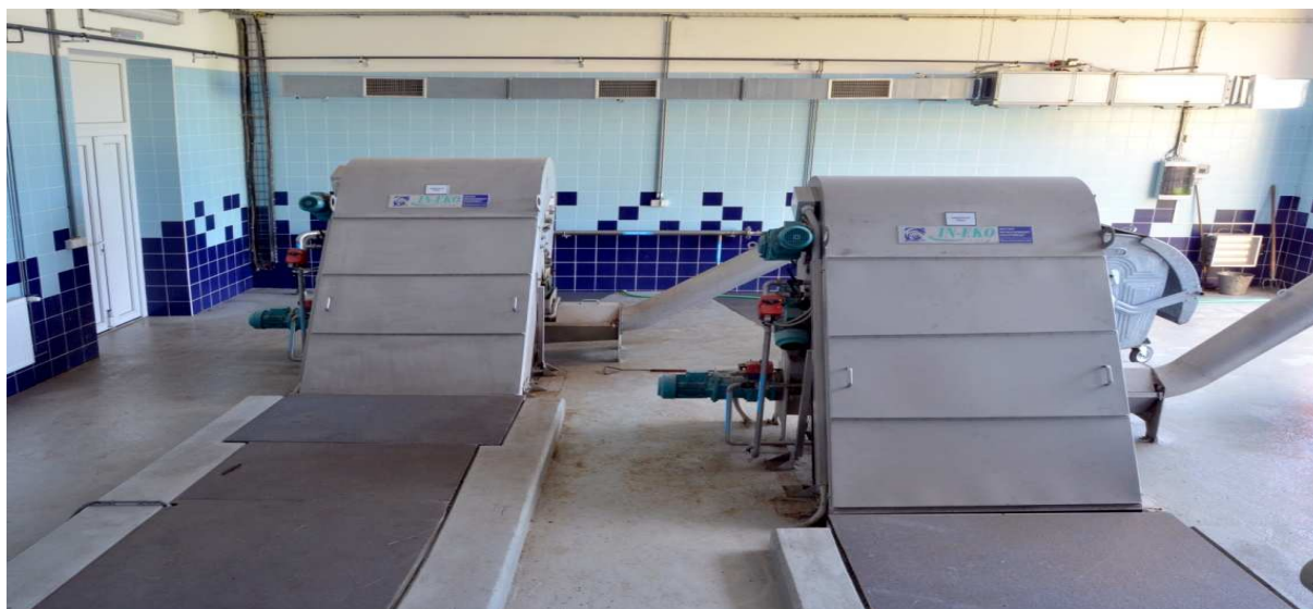
Obrázek č.11 Pohled na česlovnu ČOV Náchod - Bražec.
