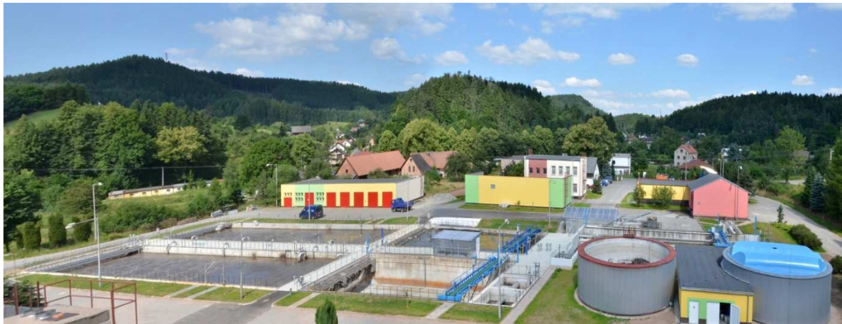
obrázek č.5 Pohled na ČOV Náchod - Bražec , Náchod
