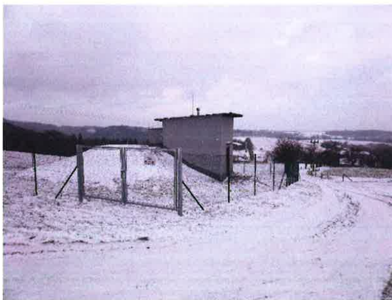
Opravený VDJ Lipí
