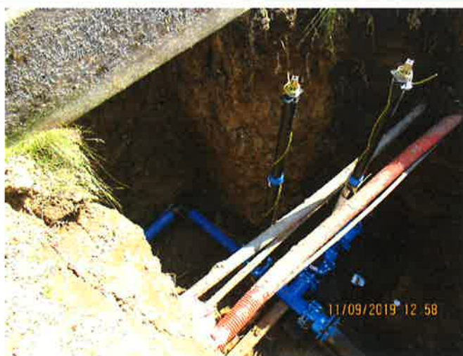
Oprava vodovodu – NAŠE NEVÝHODA - JSME HLOUBĚJI. OSTATNÍ NERESPEKTUJÍ OCHRANNÁ PÁSMA.
