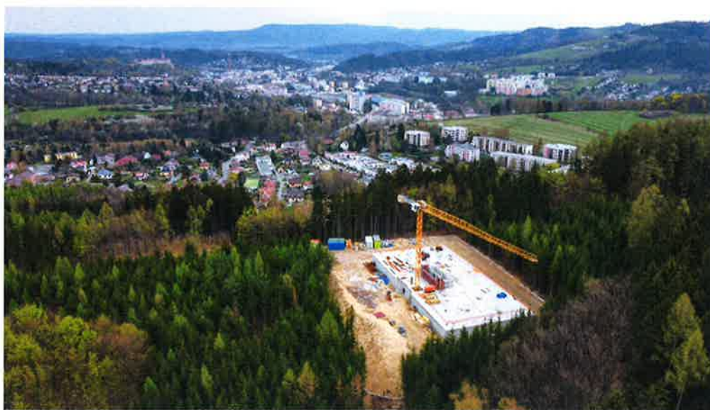
Základová deska nového VDJ Branka III.
