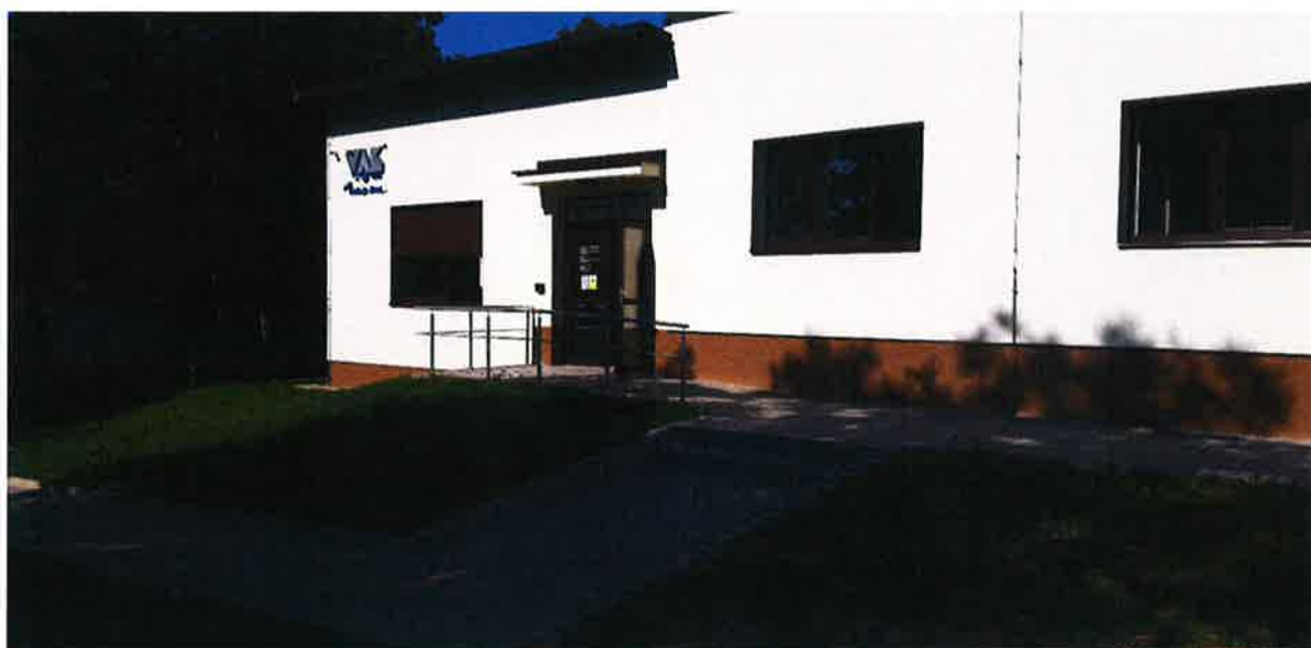
Nově zrekonstruované provozní středisko v Novém Městě nad Metují.
