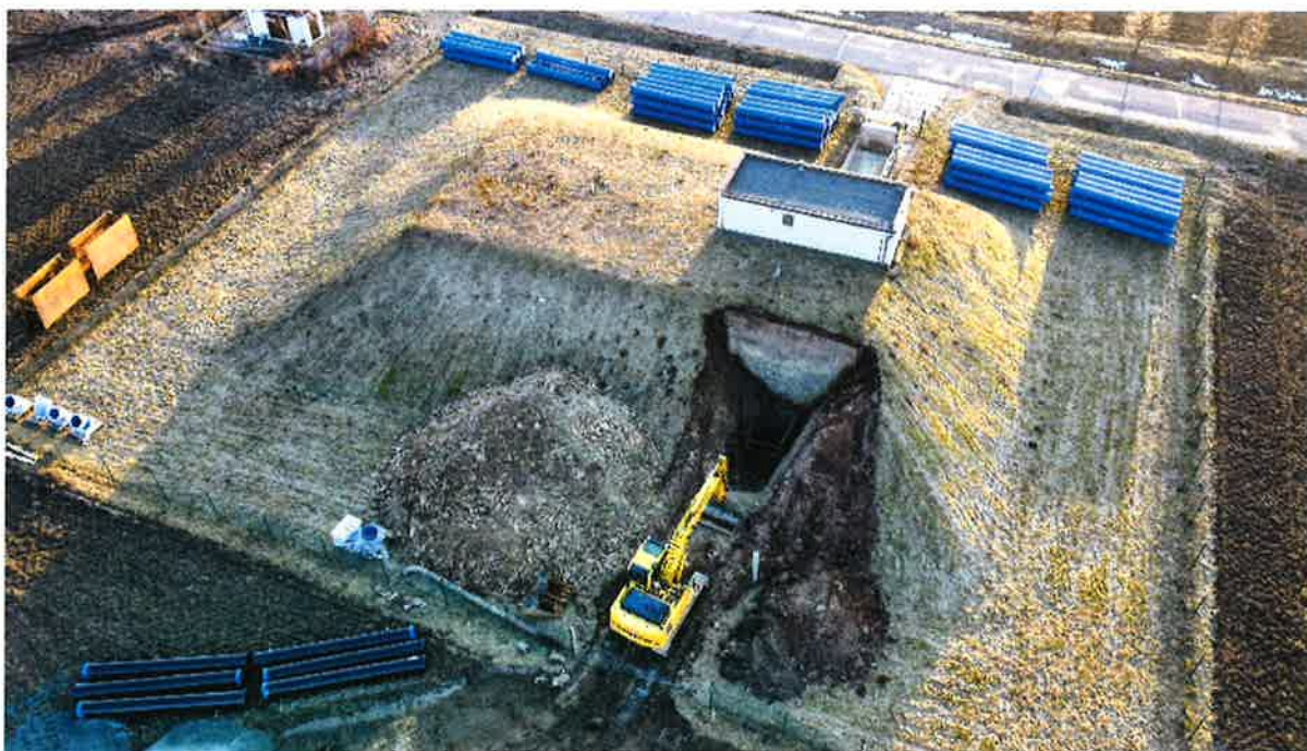
Výstavba nového vodovodního přivaděče u VDJ Vysokov.
