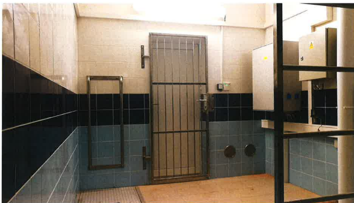
Rekonstrukce vodojemu Heřmánkovice.
