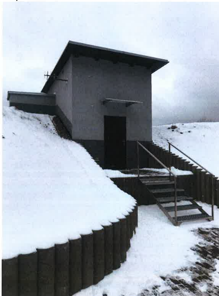
Rekonstrukce vodojemu Heřmánkovice.
