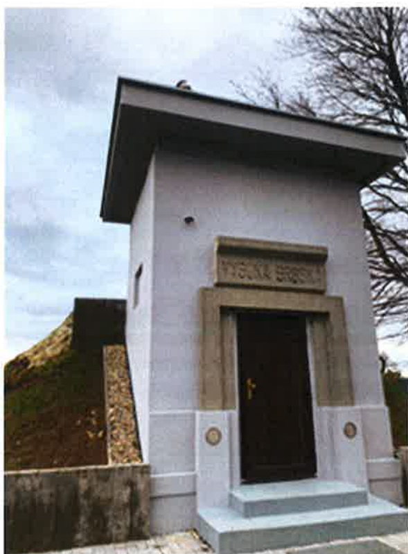
Opravený VDJ Vysoká Srbská.
